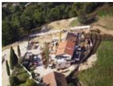
Chantier vue du Rocher du Cornillon (Novembre 2006)
